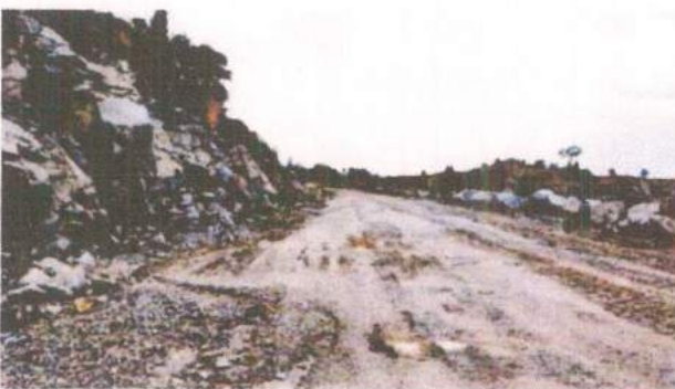
รูปที่ 5 เส้นทางลำเลียงแร่ ทำหน้าที่เสมือนคันทำนบเบี่ยงเบน น้ำให้ไหลลงสู่บ่อดักตะกอน
