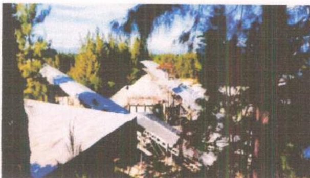
รูปที่ 15 ติดตั้ง Metal Sheet ปิดคลุมสายพานลำเลียง
